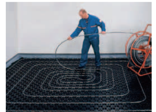
Рис. 3. Процесс укладки «теплого пола».
